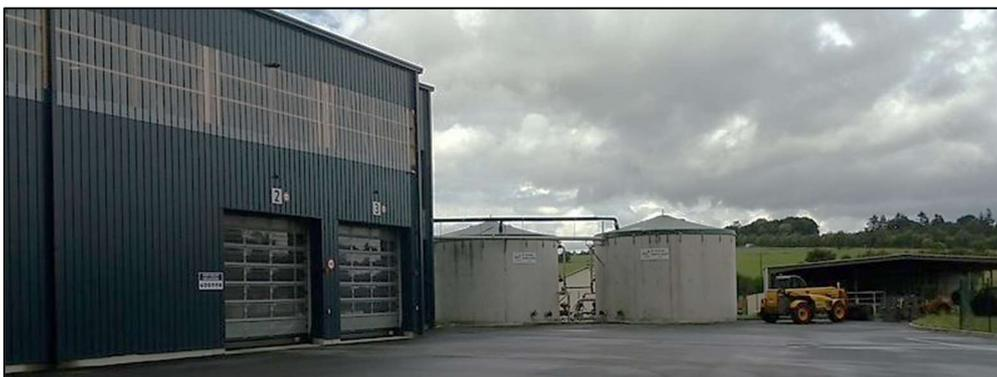
**Photo 4 : Vue des 2 cuves de stockage digestat de 200 m3**
