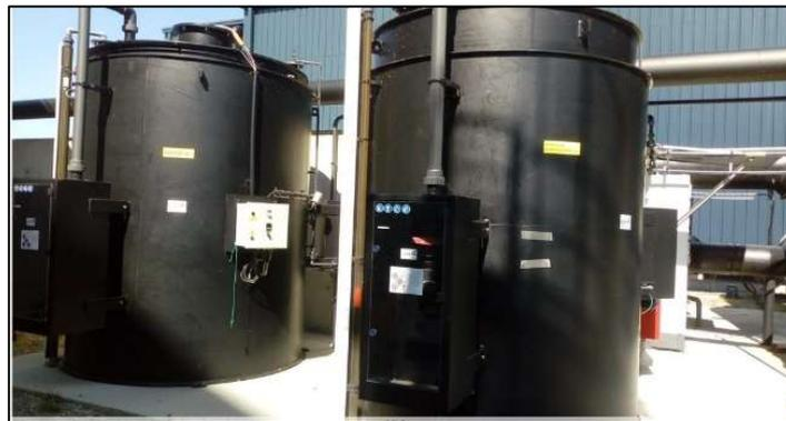
Photo 5 : Cuves de stockage réactifs
