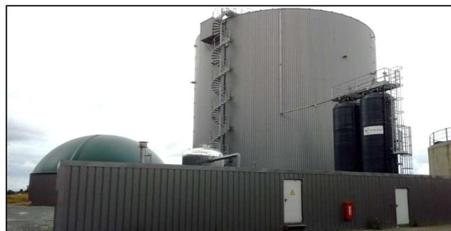
**Photo 3 : Vue du digesteur et du post-digesteur sur site**
