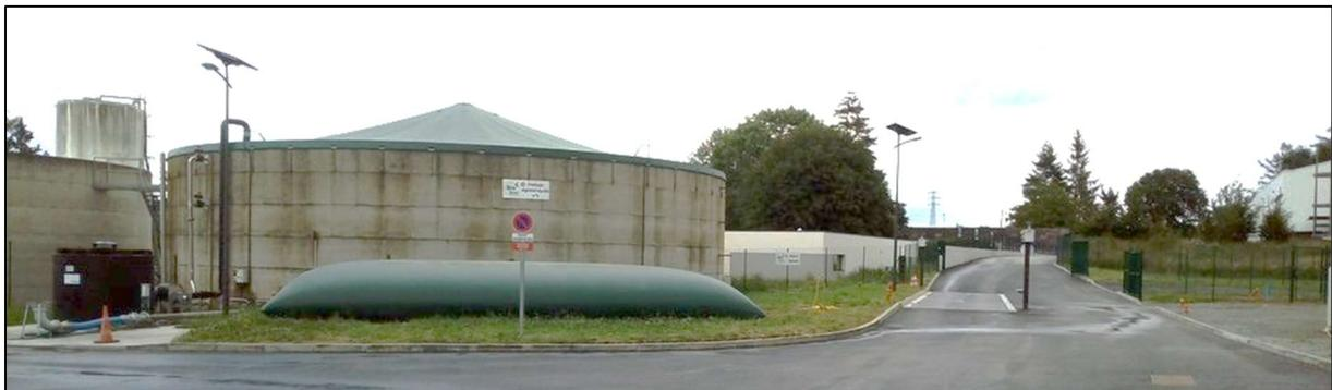
Photo 1 : Cuve de stockage digestat couverte
